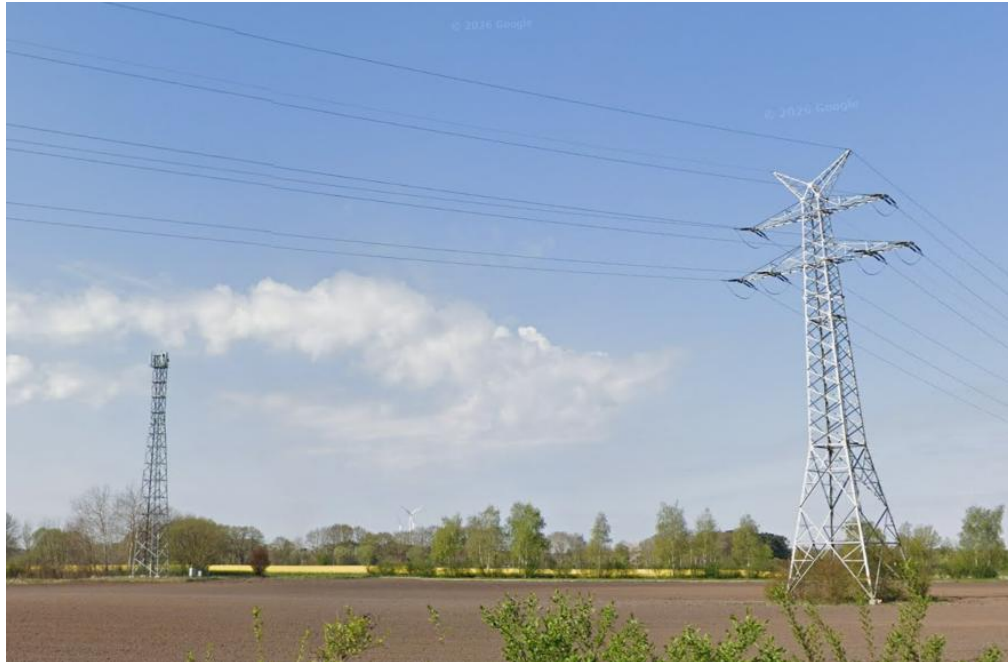
Abbildung 2: Blick auf die 110-kV-Freileitungstrasse von Alter Kirchweg 10 aus, Quelle: Google maps, Stand der Aufnahme: 04/2022
