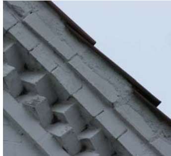
Ziermauerwerk und Mörtelband
