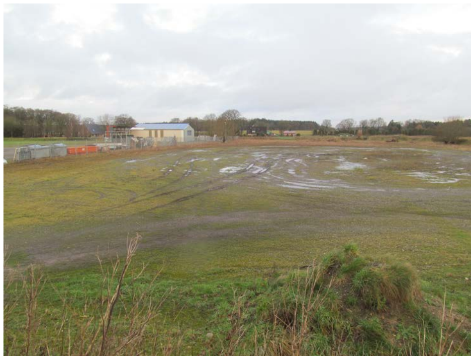
Bild 2: Ansicht auf das Baufeld am 16.01.2018
