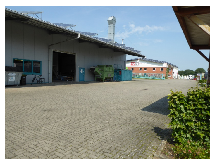
Abb. Abluftkamin über Dach
