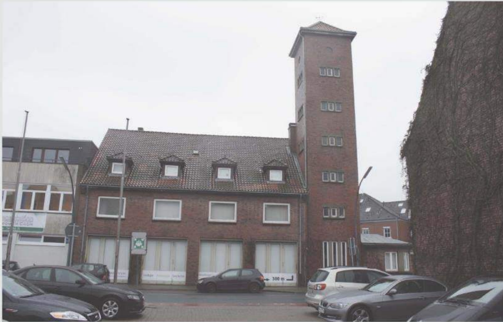
Alte Feuerwache Bremervörde -Bestand-
