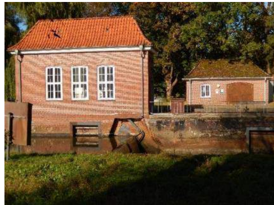
Abb. 26: erhaltungswürdiges Betriebsgebäude und Schleusenwärterhaus
