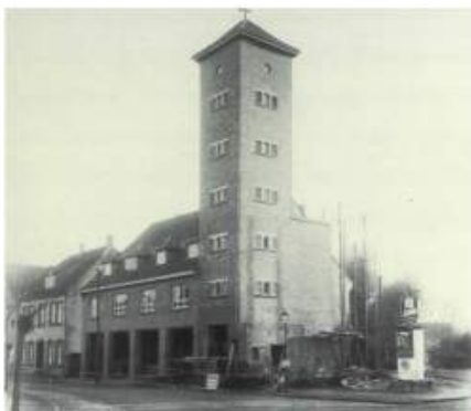
Abb. 1: Die Alte Feuerwache Bremervörde kurz vor ihrer Fertigstellung im Jahr 1937. Durch die noch fehlenden Tore wird deutlich, wie gut eine Öffnung des Erdgeschosses möglich ist.
