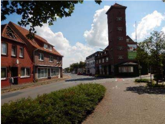
Abb. 19: „Alte Feuerwache“, Ansicht von Nordwesten
