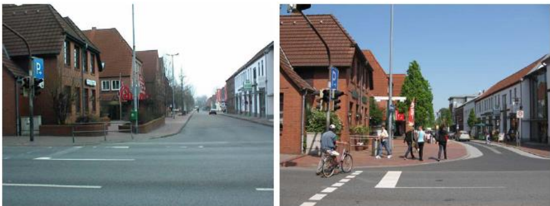
Abbildung 5: Marktstraße vor und nach dem Umbau. Q: Stadt Bremerörde (2008): Sanierungsmaßnahmen "Bremerörde - Innenstadt (II)"
